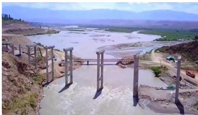
Строительство эстакадных мостов
