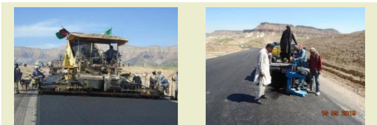
Рисунок 13. Строительные работы на 80-м км автодороги от Герата
