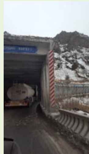
Тоннель на перевале "Too-Ashuu"
